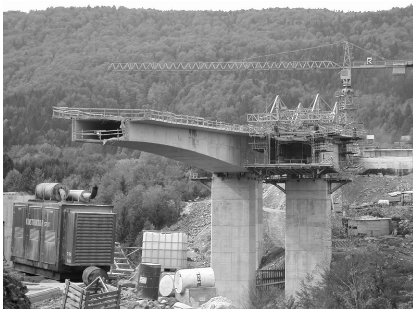
konzolna gradnja mosta Kamačnik
