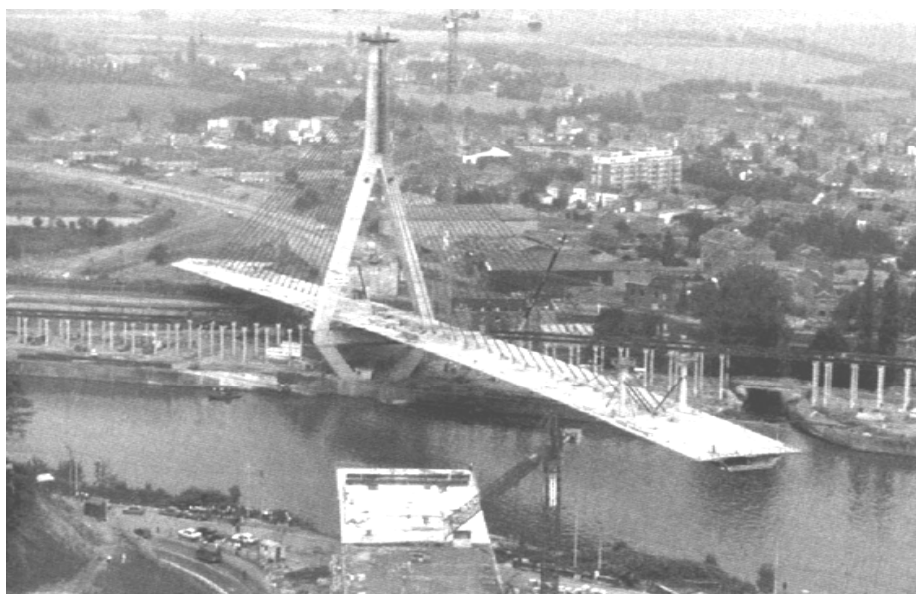
poprečno zakretanje mosta sagrađenog na skeli na obali
