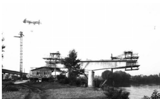
konzolna gradnja mosta preko Save u Jasenovcu
