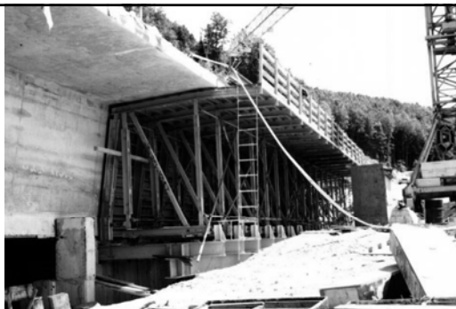
izrada odsječka u radionici kod upornjaka
