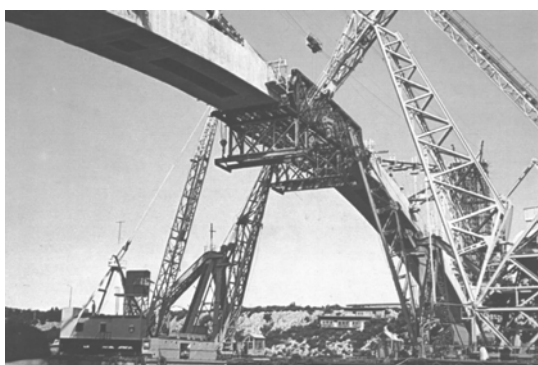
gradnja Šibenskog mosta
